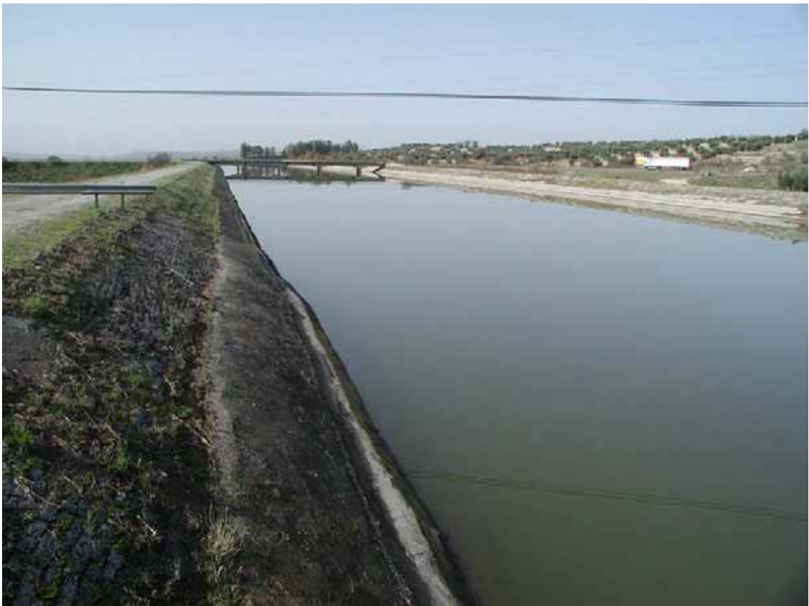
Canal de Castrejón que desvía las aguas del Tajo para su aprovechamiento hidroeléctrico y de regadíos
